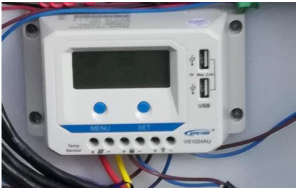
如图所示, 太阳能(红黄)和蓄电池的电缆红蓝两根线。
